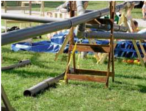
So sieht eine Wasserbaustelle aus.
